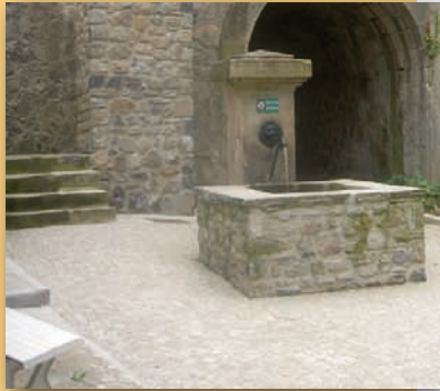
La fontaine rénovée de la rue basse
