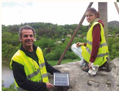
Installation de l'éclairage solaire
