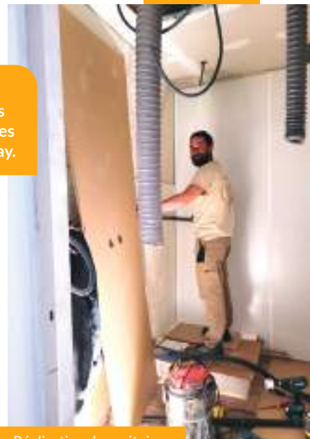
Réalisation de sanitaires
