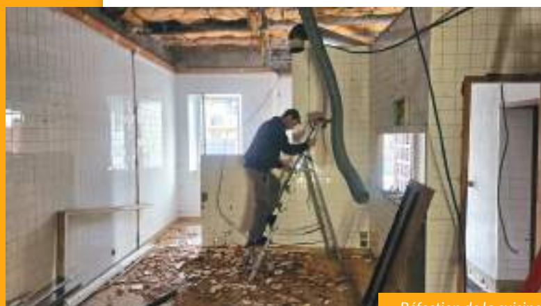
Réfection de la cuisine
