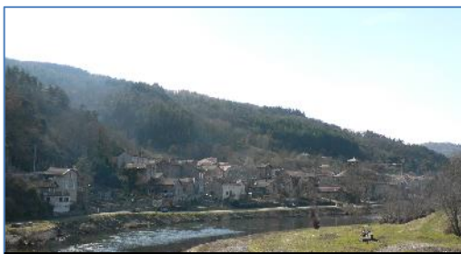
Vue du pont D35 sur le Bourg ainsi que l'église Saint Gilles et l'ancien prieuré
