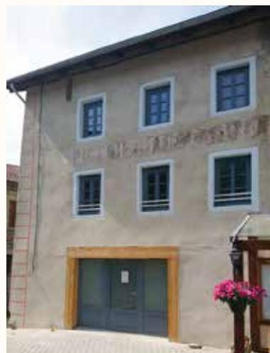
Rendue indispensable par l'état du bâtiment, cette phase de réfection conclut les travaux d'installation du cabinet infirmier. Elle a impliqué la mise en œuvre d'un enduit au mortier de chaux et la réalisation d'une chaîne d'angle en badigeon. Un souci particulier a été apporté
