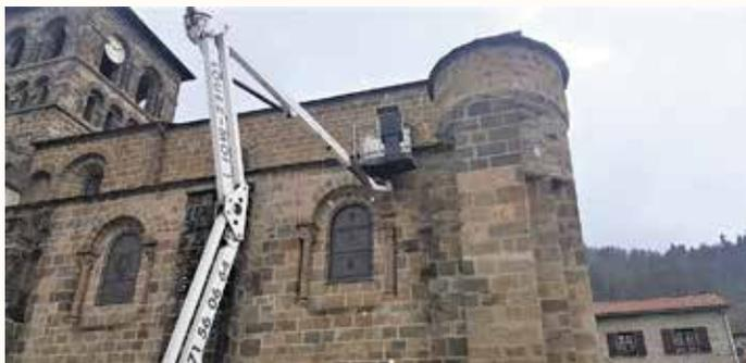
Ces travaux ont consisté en deux phases principales : la dévégétalisation de l'ensemble de la toiture et la remise en place des lauzes pour préserver l'étanchéité. Les travaux ont été réalisés par l'entreprise Velay couverture Charpente de Saint-Pierre-Eynac pour un coût de 7 165 €HT subventionné à hauteur de 56 %.
