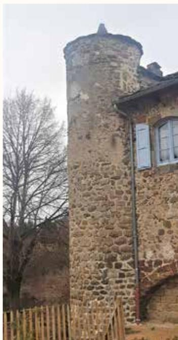
Fortement détériorée, la tourelle a nécessité une reprise en maçonnerie au mortier de chaux et la remise en place de pierres de pays. Ces travaux ont été effectués par l'entreprise Paulet de Beaux pour un coût de 3 300 €HT subventionné à hauteur de 25%.
