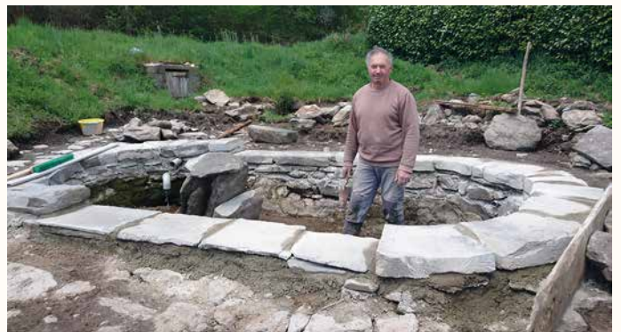
Les lavoir, bacha et fontaine du Mazer
